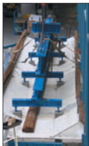
Prefabbricazione di tegoli di copertura
